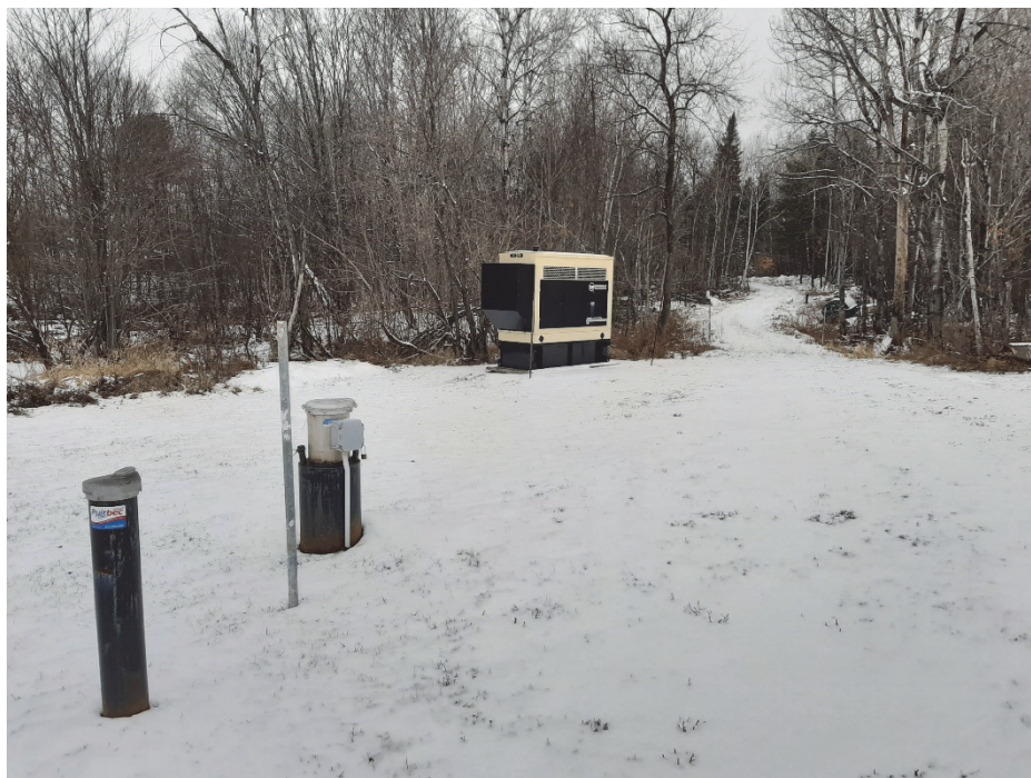
Photo 1 : Aperçu du puits P-1 - 2020-12-11
