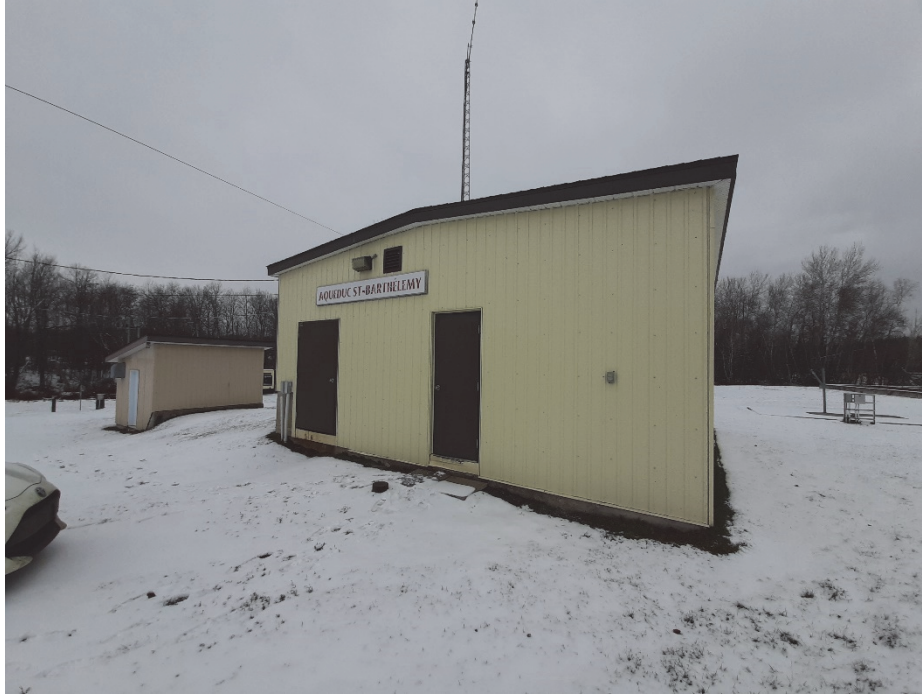
Photo 6 : Aperçu du bâtiment de production d'eau potable – 2020-11-12
