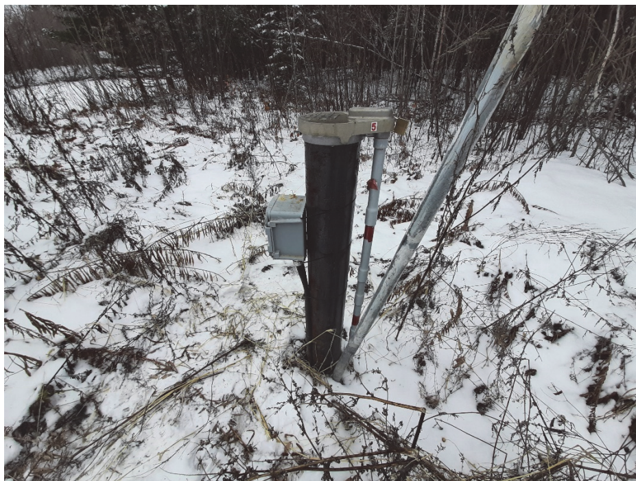
Photo 5 : Aperçu du puits P-5 - 2020-11-12
