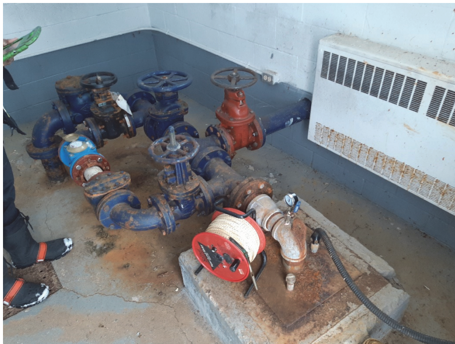
Photo 3 : Aperçu du puits P-3 - 2020-11-12
