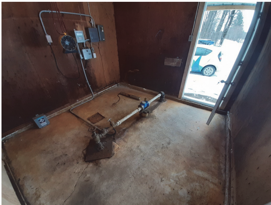
Photo 2 : Aperçu du puits P-2 - 2020-11-12
