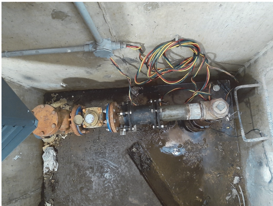
Photo 4 : Aperçu du puits P-4 - 2020-11-12
